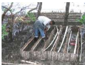
ujenzi wa vizimba vya kaa
